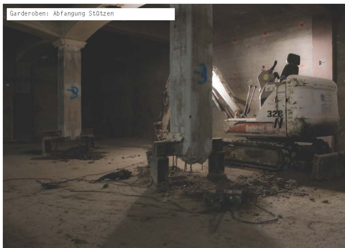
Sanierung und Grundinstandsetzung der Staatsoper Unter den Linden, Berlin 2010-2015
