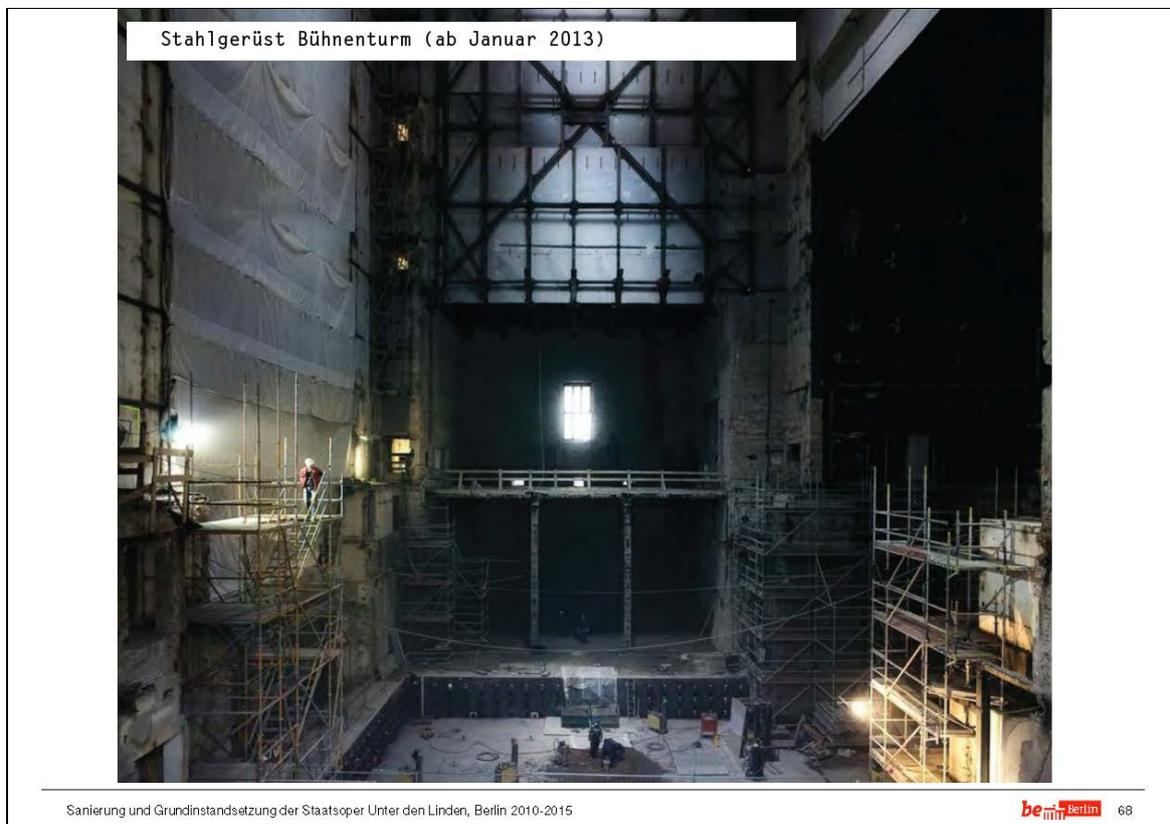
Sie sehen, wie auf der fertigen Abdichtung des Bühnenturmes dieses Gerüst aufgestellt wird.
