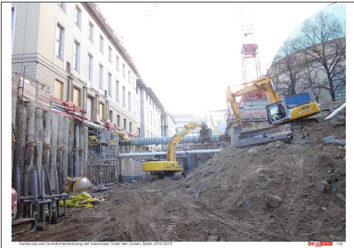
Und das ist dann der Übergang aus dem unterirdischen Bauwerk in die Seitenbühne – Berlin Seite – hinein. Eine entsprechende Öffnung in der Bohrpfehlwand ist schon vorgesehen.
