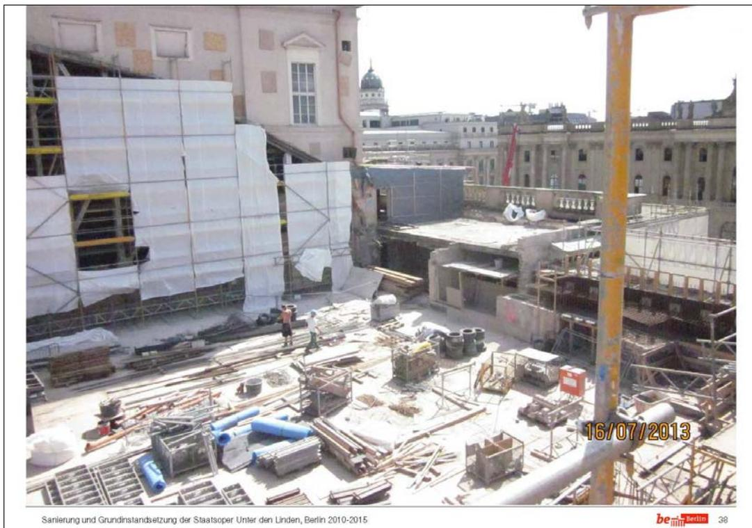
Das ist jetzt eine Fotoreihe aus dem Spätsommer und Frühherbst, wo dieser neue Ringbalken dort montiert wird. Das ist eine Stahlfachwerkkonstruktion, damit es möglichst leicht ist.
