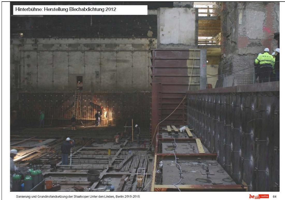
Hier schon ein weit fortgeschrittenes Foto. Hier kann man erkennen, wie unten schon fast alles fertig ist, wie die großen Stützenfundamente abgedichtet werden.
