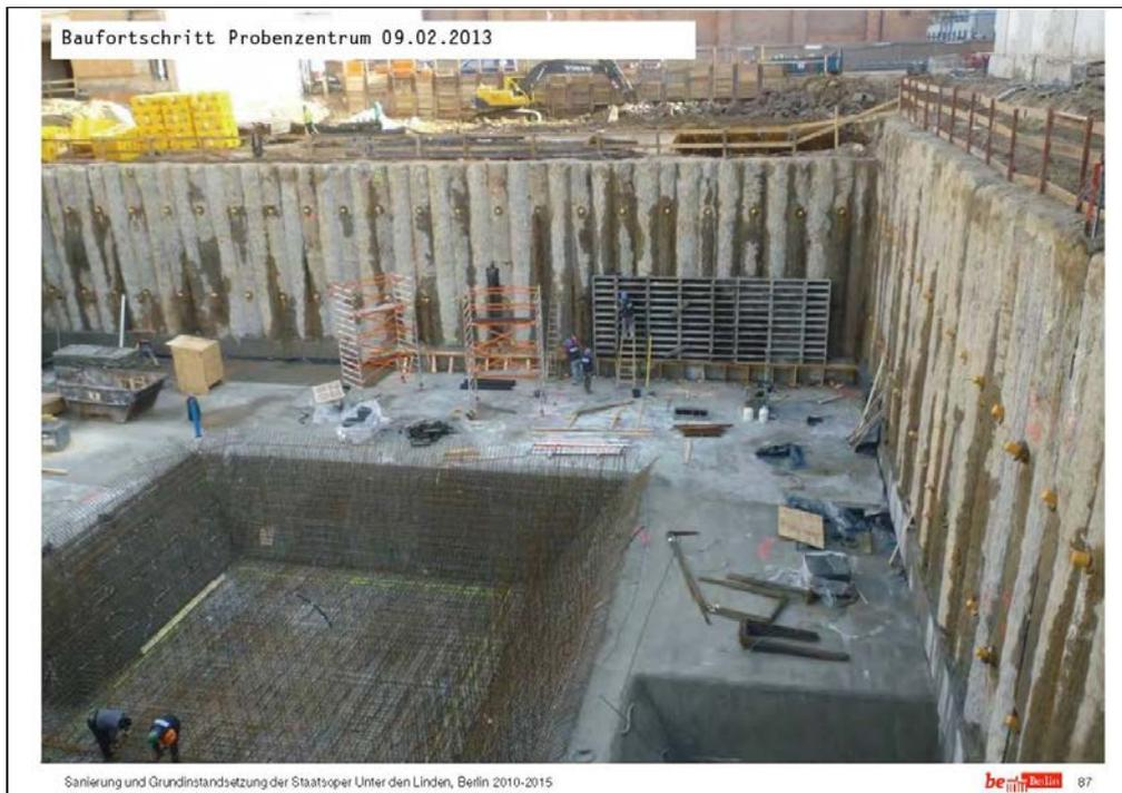
Hier sehen Sie ein Foto, wo schon die erste Bewehrung liegt. Das, was hier unten so tief liegt, ist die Unterfahrt für dieses Hubpodium, das die ganzen Sachen nach oben und unten fährt. Sie sehen, dass angefangen wird, die Wände einzuschalen.
