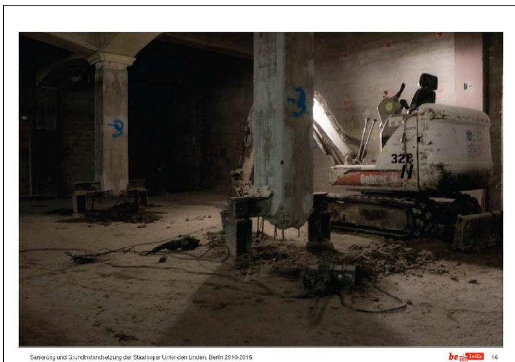
Das nächste Foto ist ein Foto in den Zuschauerraum hinein. Das ist noch aus dem Jahr 2012 und zeigt das Einbringen der Unterwassersohle, der Schwerlastsohle, gegen den entsprechenden Auftrieb.
