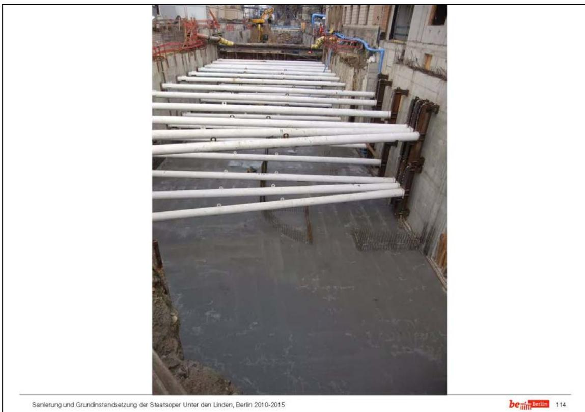
Hier sind die Betonarbeiten für die Wände und die Stützen des unterirdischen Bauwerks im Gange. Die untere Aussteifungsebene an Stützen ist zum großen Teil schon wieder herausgenommen worden, weil natürlich das Ganze jetzt von der Sohle geleistet wird.
