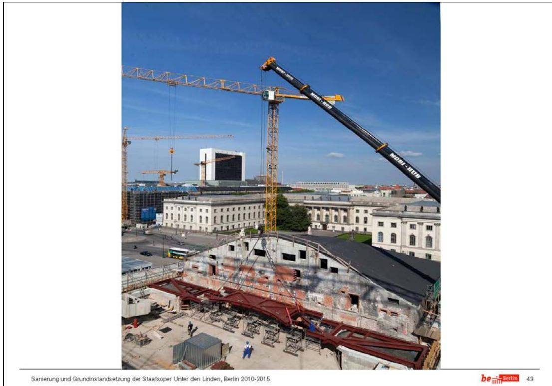
Das Dach wird dann künftig über diesen wesentlich schlankeren Dachträger getragen. Sie können jetzt auch schon erkennen, dadurch, dass er so schlank ist und dass es keine Zugbänder mehr gibt, weil künftig dieser Ringbalken die Lasten aufnimmt, entsteht hier genügend Volumen für die Nachhallgalerie.
