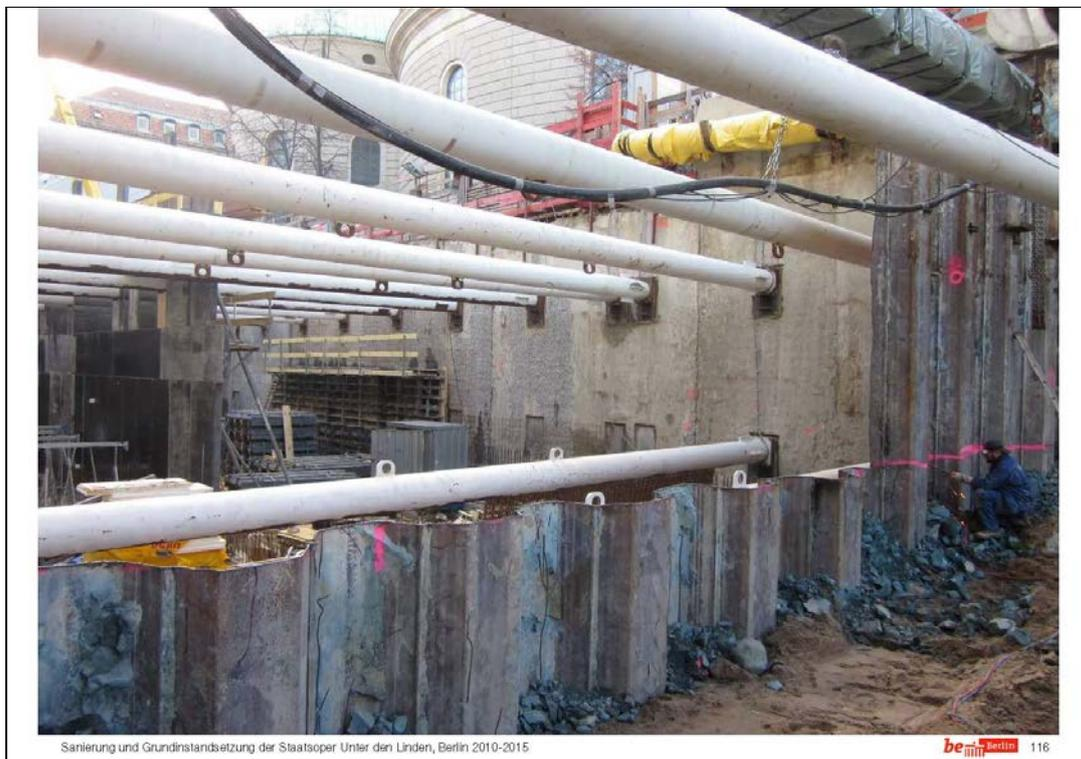
Und das hier noch mal in der Perspektive. Was Sie hier vorne sehen, sind schon die Wände des unterirdischen Bauwerks, die entlang der Schlitzwand dann aufgestellt werden.
