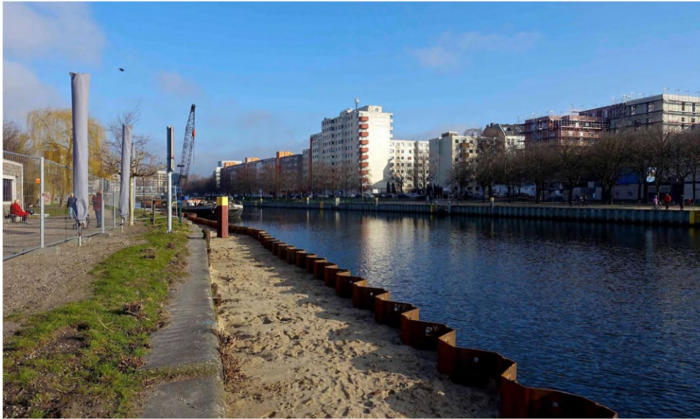
Spree/Charlottenburg – Vorbereitung der Ufersicherungsmaßnahmen Bauträger ist Land Berlin
