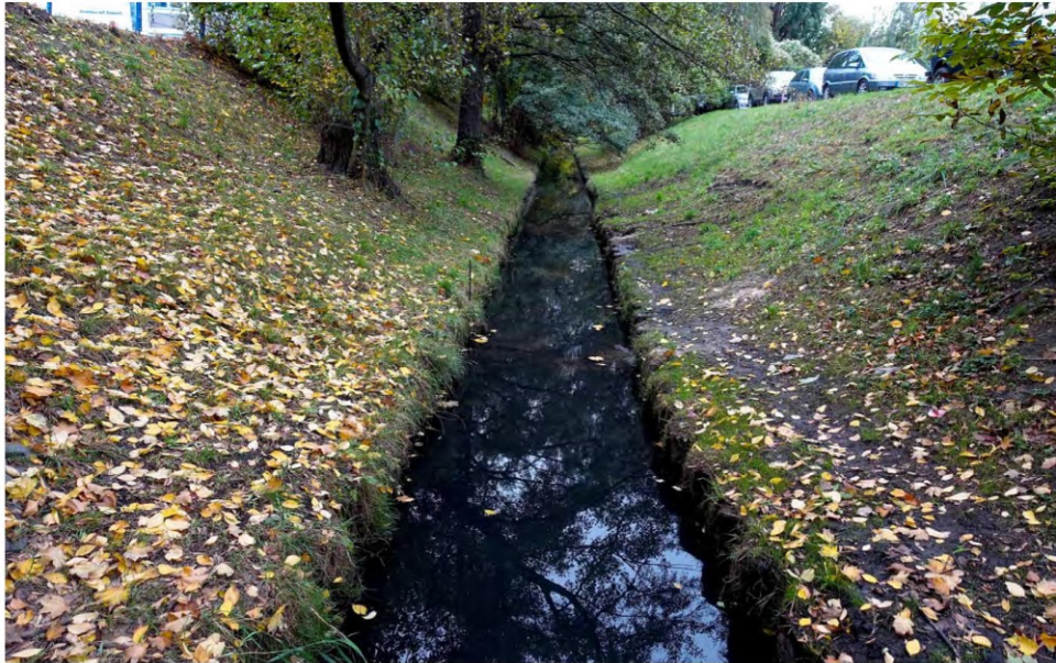
Grützmachergraben/Spandau - Unnatürliches Kastenprofil, schlechte Wasserqualität
