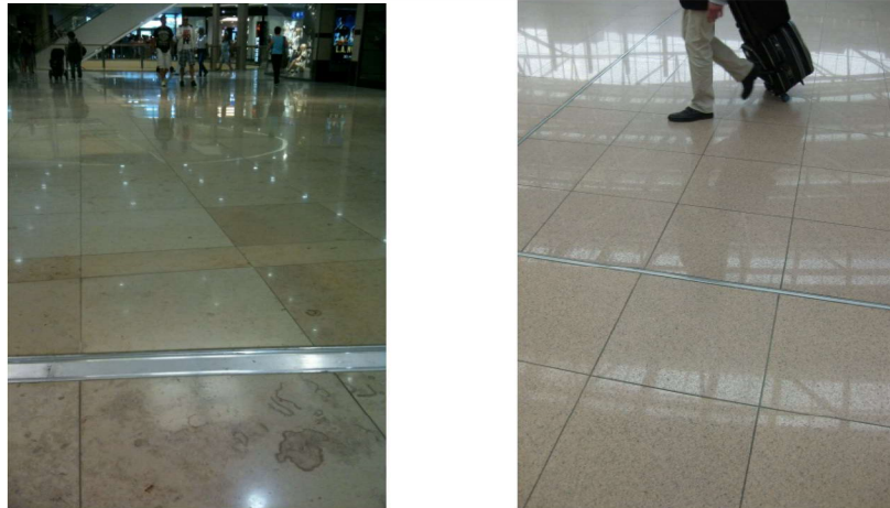
Negativbeispiele spiegelnder Bodenbeläge (Quelle: Ferger-Heiter, Dürrer)
