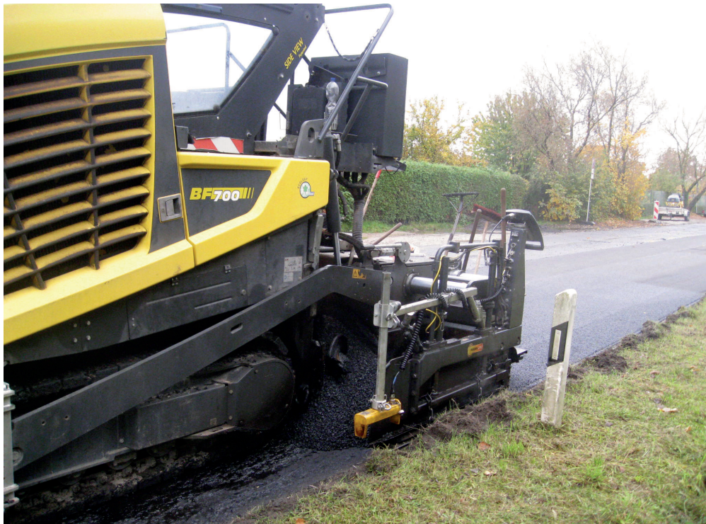
Abbildung 1: Neuer Asphalt wird aufgebracht
