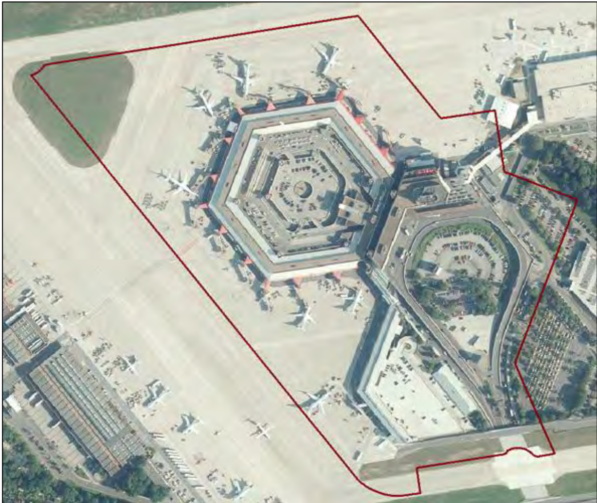
Abb. II.4: Luftbild des Geltungsbereiches zur Darstellung der Versiegelung im Ist-Zustand
