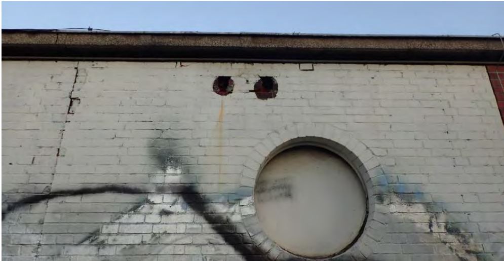
Abbildung 16: Gebäude mit Hohlräumen, welche von gebäudebewohnenden Fledermäusen genutzt werden könnten
